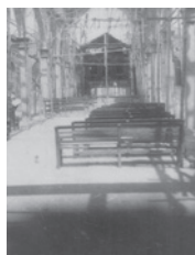
Proceso de construcción del Templo
